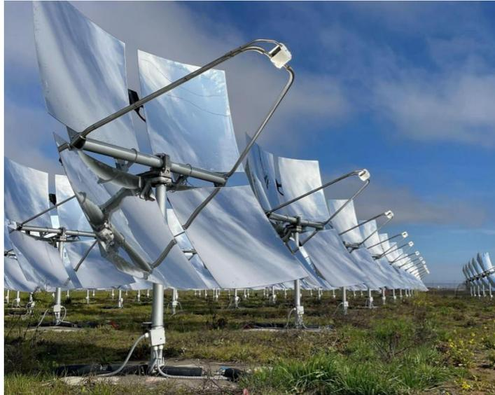
Figura 60. Sistema disco parabólico Sunspin (Kalido, 2024)
