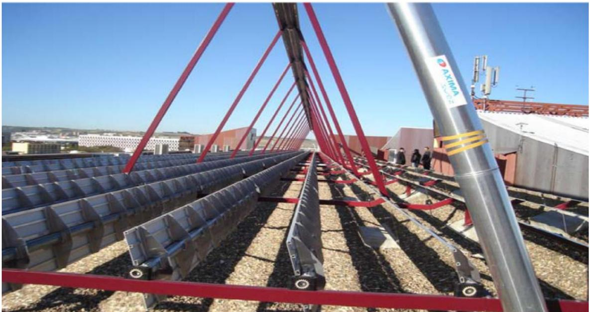
Figura 54. Estructura de acero del captador solar (ETSI de la Universidad de Sevilla).
