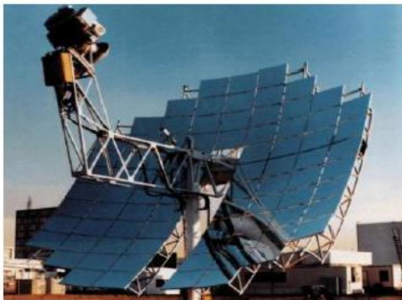
Figura 62. Captador del sistema Vanguard (Stine & Diver, 1994).
