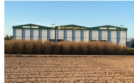
261 kWp (Elche; Alicante)
