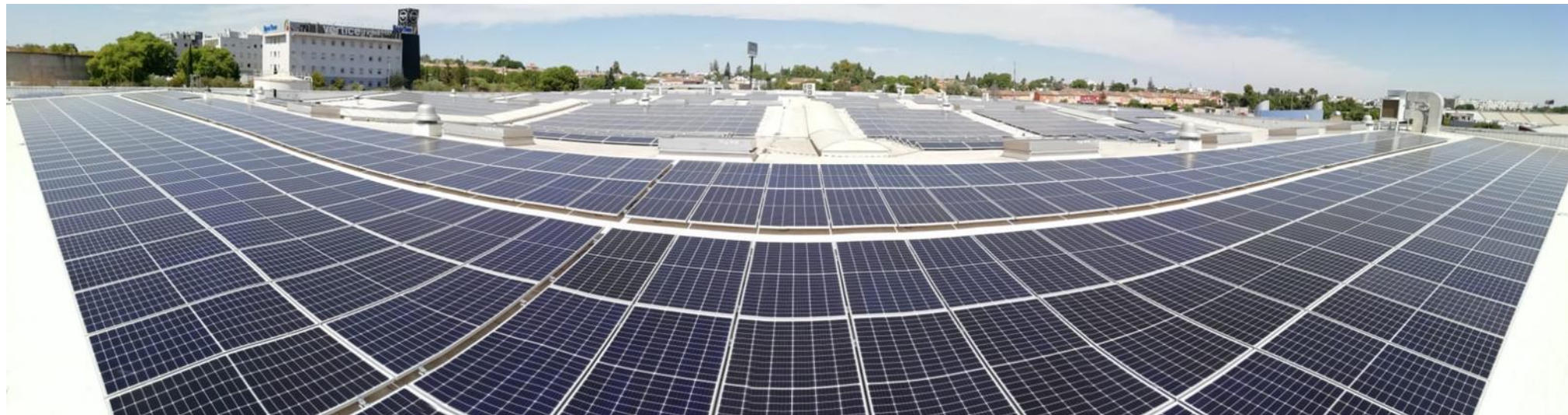
Instalación solar FV Makro Bormujos (Sevilla)
