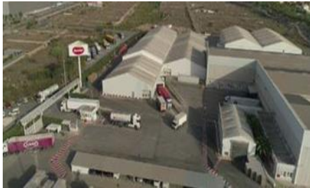
1.200 kWp (Churra, Murcia)
