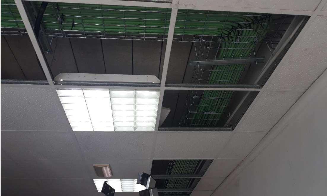
Canalización bandeja metálica por falso techo
