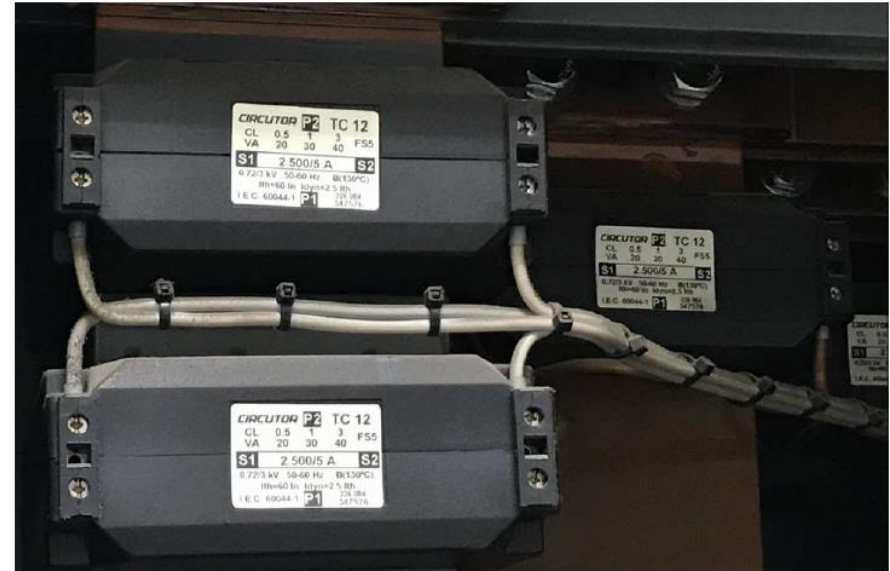
Transformadores de intensidad sistema antivertido
