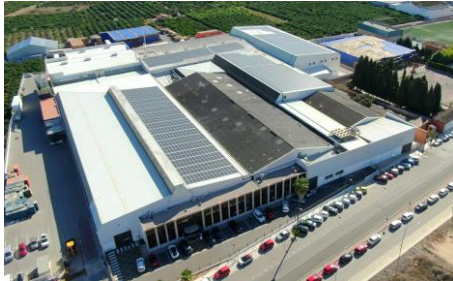
915 kWp (Benifairó de la Valldigna, Valencia)
