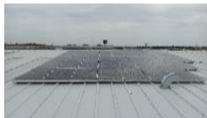
17 kWp (Alcorcón; Madrid)
