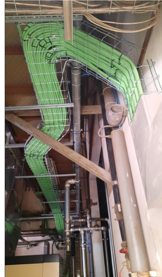
Canalización bandeja metálica
