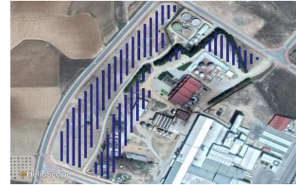
2.300 kWp (Villarrobledo; Albacete)
