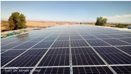
390 kWp (Marcilla, Navarra)
